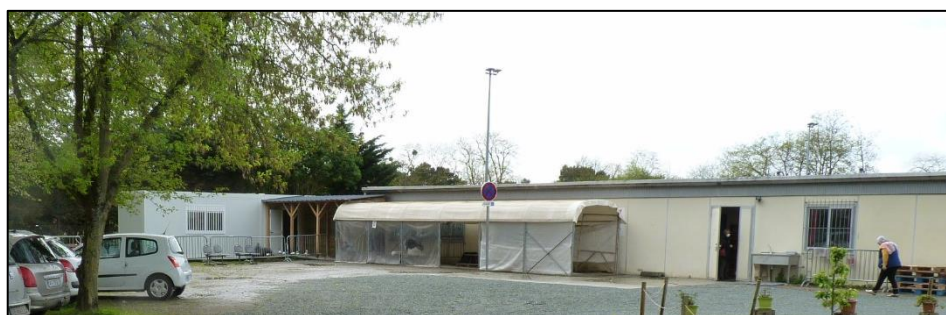
Adjonction d'un modulaire de 72 m 2
